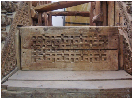
شکل ۶: فروریختن سه پله انتهایی و استفاده از میخ‌های فلزی در منبر فرزند و بست‌های فلزی منبر فریزهند (عکس: نگارنده ۱۳۹۳)
