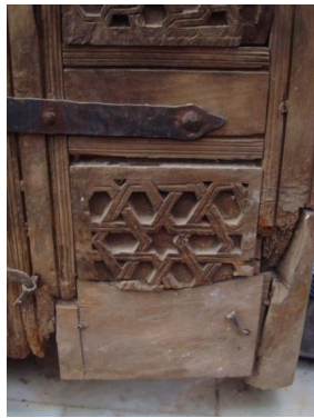
شکل ۵: مرمت غیر اصولی و استفاده از میخ (عکس: نگارندگان، ۱۳۹۳)
