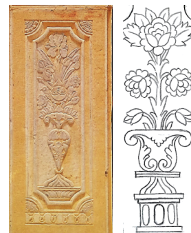
تصویر ۶: تصویر و طرح درختچه گل‌رز؛ پایه ستون ایوان قلعه شلمزار (نگارندگان، ۱۳۹۳)
