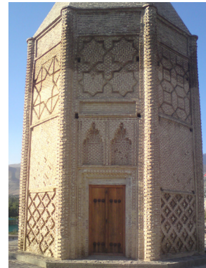
تصویر ۳- برج شبلی دماوند با استفاده از بخش‌بندی و کادر مستطیل، هر ضلع در جهت طولی به سه قسمت مجزا تقسیم شده است (نگارنده، ۱۳۸۹)
