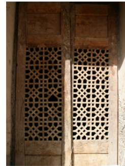
شکل ۱۸- کاربرد گره‌سازی در ساخت درب مشبک در خانه عبداله‌بیک مسینایی (آرشیو شخصی محمدعلی بزرگمهر)
