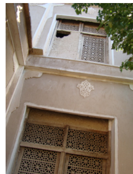
شکل ۲۶- طراحی و ساخت پنجره‌های طبقه همکف و بالانشین با هنر گره‌چینی (آرشیو اداره کل میراث فرهنگی خراسان جنوبی، ۱۳۸۲)
