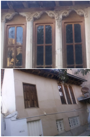
تصویر ۴: الف و ب: پنجره‌های خانه حاج قاسمی همراه با تزئینات گچ‌بری، بنای شمالی جنوبی (نگارندگان، ۱۳۹۸)
