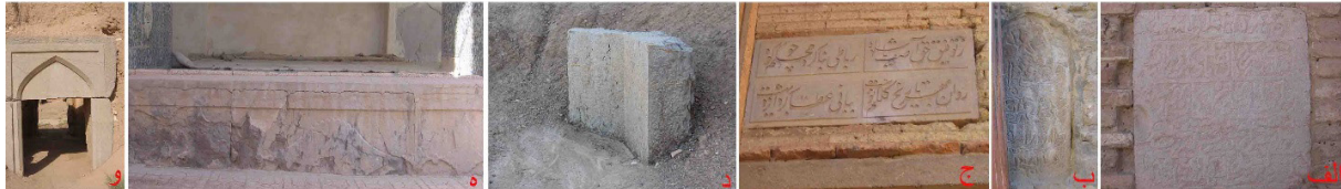
تصویر ۱۲: آرایه‌های سنگی (الف) کتیبه سنگی مسجد گز (ب) کتیبه سنگی مسجد گز (ج) کتیبه سنگی کاروانسرای شیخ علیخان (د) ازاره سنگی مدرسه جعفرآباد (ه) ازاره سنگی سردر مدرسه جعفرآباد (و) قاب بند سنگی سردر مدرسه جعفرآباد (نگارنده: ۱۳۸۴ و ۱۳۸۶).
