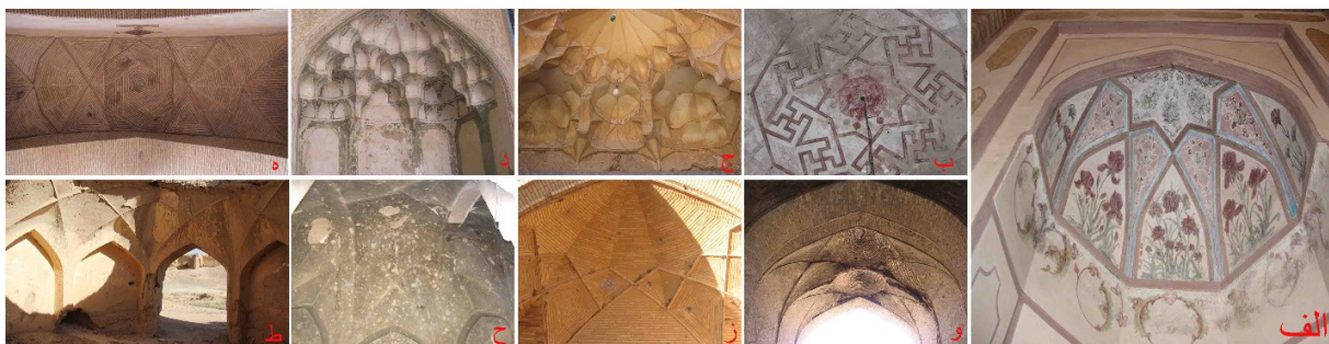
تصویر ۱۱: الف) دیوارنگاره‌های محراب مسجد گز ب) دیوارنگاره‌های بقعه عبدالمؤمن ج) آرایه مقرنس‌کاری مسجد گز د) آرایه مقرنس‌کاری بقعه عبدالمؤمن ه) آرایه کاربندی مسجد گز و) آرایه کاربندی کاروانسرای گز ز) آرایه کاربندی کاروانسرای شیخ‌علیخان ح) آرایه کاربندی خانه حاج عابدی‌های شاپورآباد ط) آرایه کاربندی مدرسه جعفرآباد (نگارنده: ۱۳۸۴ و ۱۳۹۸).
